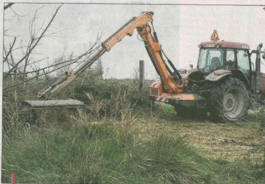
Les premiers travaux de débroussaillage viennent de démarrer.
